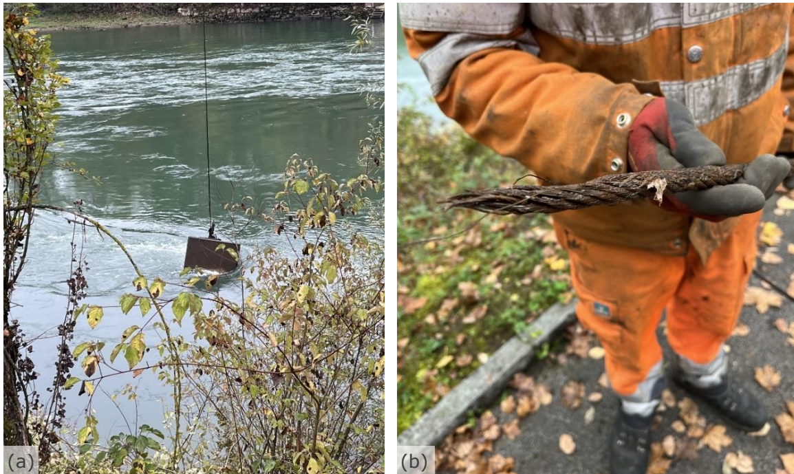
Abb. 7.4 (a) Betonklotz während des Rückbaus der Aussenstation bei Brugg und (b) beim Rückbau gerissenes 16 mm dickes Stahlseil.
