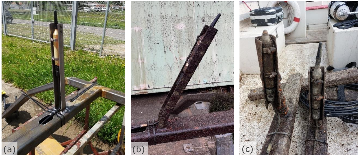
Abb. 7.5 Das beim Mittelpfeiler sohnah positionierte Hydrophon (a) vor der Installation am 13.05.2019, (b) beim Rückbau am 21.10.2022 und (c) weitere verbogene beschädigte Hydrophone (Aufnahmedatum 07.09.2022).
