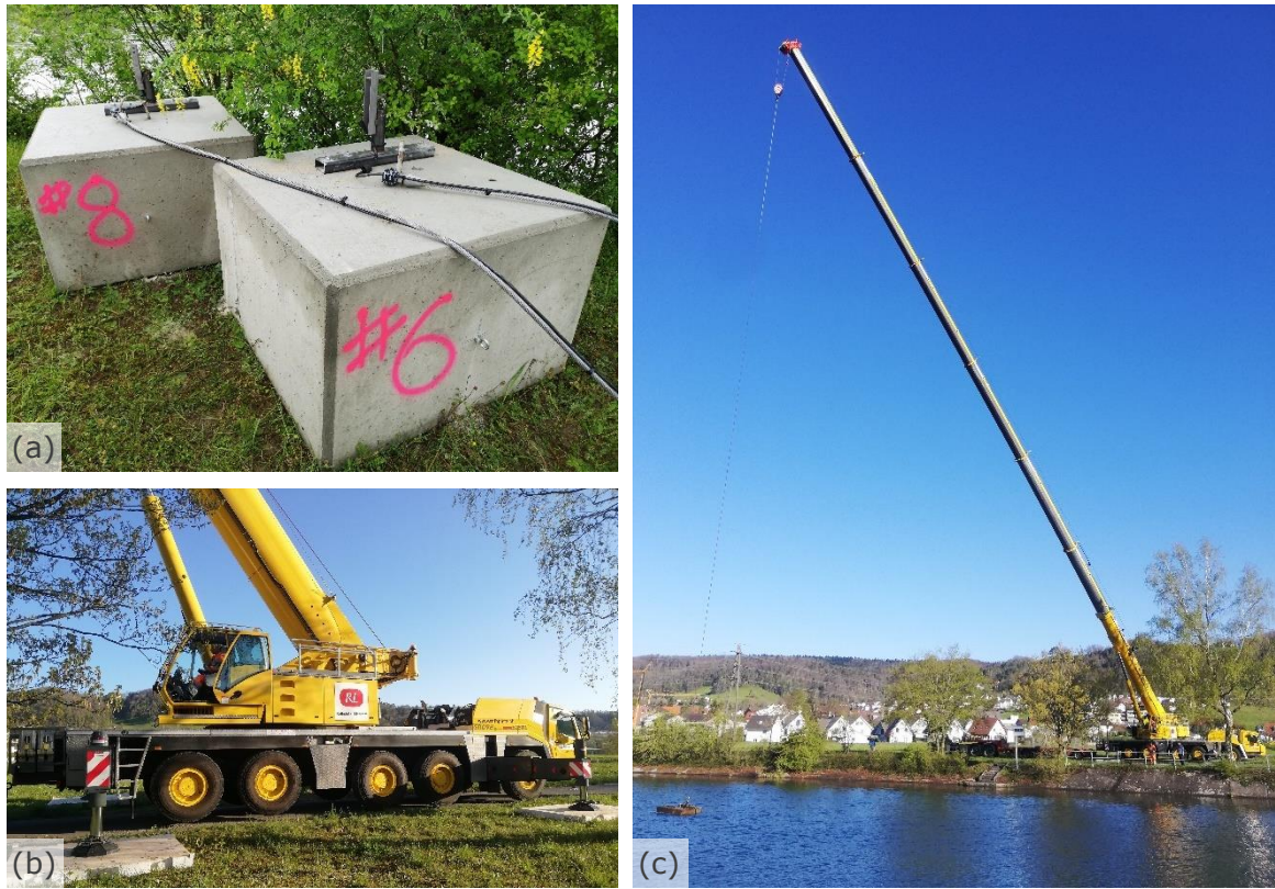
Abb. 4.5 (a) Zwei jeweils knapp drei Tonnen schwere Betonklötze mit aufgesetzten Hydrophon-Halterungen, welche im Oberwasserkanal des KWWB positioniert wurden, (b) eine Detailaufnahme des eingesetzten Pneukrans und (c) der Pneukran mit ausgefahrenem Ausleger beim Setzen eines Hydrophons im Oberwasserkanal des KWWB.
