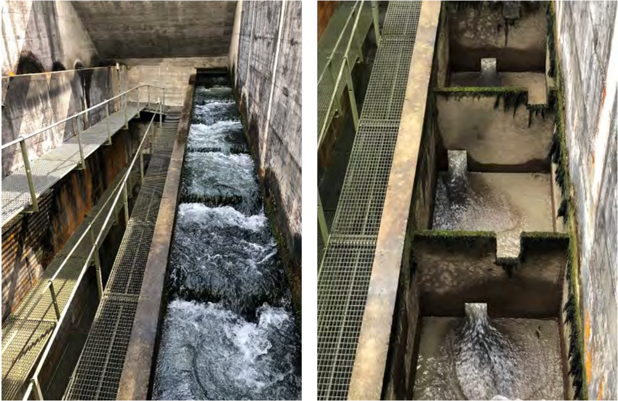
Abbildung 3: Blick auf die Fischtreppe im Lichtschacht: links im Betriebszustand, rechts mit fehlendem Abfluss infolge einer Reinigung der Fischtreppe. Hier sind die Schlupflöcher am Boden und die Kronenausschnitte an der Oberfläche erkennbar.
