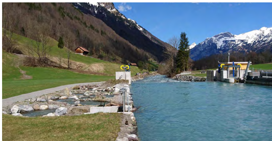
Kraftwerk Rufi, auf der linken Seite der Fischausstieg des Umgebungsgewässers. Rechts die Fassung in den 3-Kammer-Entsander.
