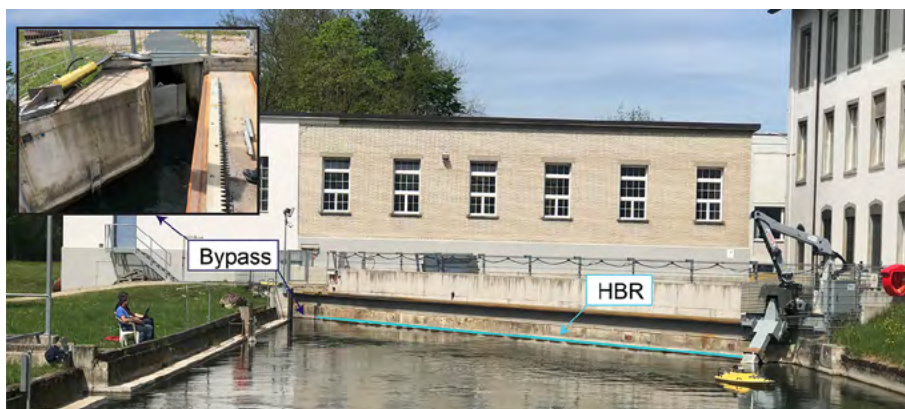
Bild 1: Das Laufwasserkraftwerke Stroppele in der Gemeinde Untersiggenthal (AG) ist mit einem horizontalen Fischleitrechen (HBR) ausgerüstet, der die in der Limmat lebenden Fische (u. a. Schneider, Barben und Rotaugen) in einen Bypass leitet, damit sie am Kraftwerk vorbei flussabwärts wandern können. Bei grösseren Laufwasserkraftwerken werden Fischleitrechen bisher in Europa nicht eingesetzt (Foto: Ismail Albayrak, VAW).
