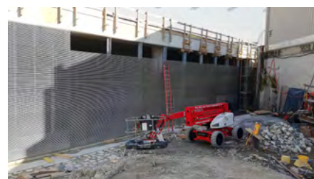
Bild 7: Das Limmat-Kraftwerk in Dietikon (ZH) verfügt seit dem vergangenen Jahr über den grössten Horizontalrechen in der Schweiz mit einer Rechenfläche von über 200m 2 und einem Stababstand von 20 mm. Das Foto wurde im August 2019 aufgenommen, kurz vor der Inbetriebnahme des Kraftwerks. Der Bypass-eingang befindet sich rechts beim Baugerüst (Foto: Julian Meister/VAW).
