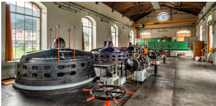
Die Maschinenhalle vor Beginn der Demontage im Herbst 2020 (Bild: Christian Helmle).
