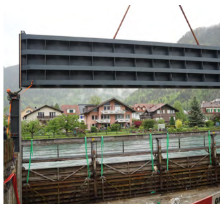
Montage des neuen Einlaufschützes im Mai 2021.
