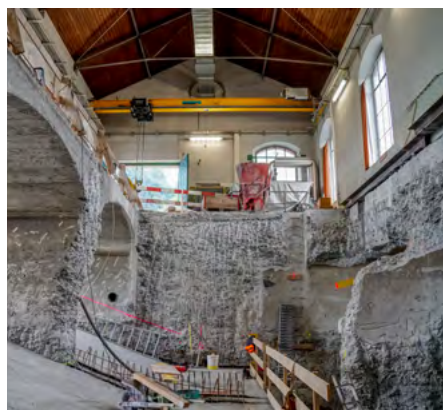
Bausubstanz aus vergangenen Zeiten: Die Maschinenhalle wurde fast komplett entkernt (Juli 2021).
