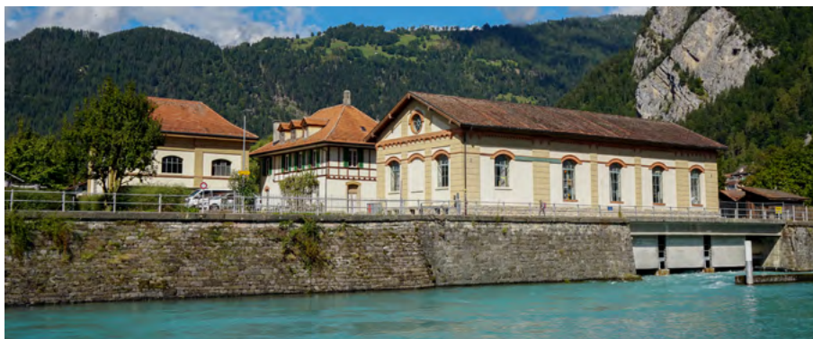
Direkt gegenüber dem Bahnhof Interlaken West liegt das älteste IBI-Wasserkraftwerk.
