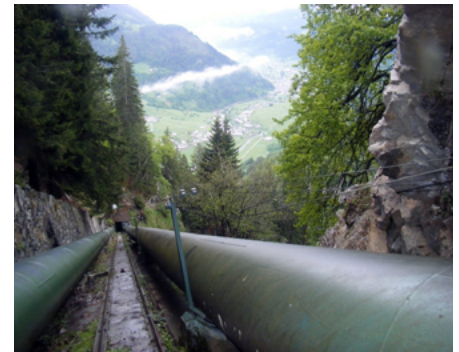
Druckleitung Balbalera, Steilstrecke mit Blick ins Puschlav (Foto: Repower).
