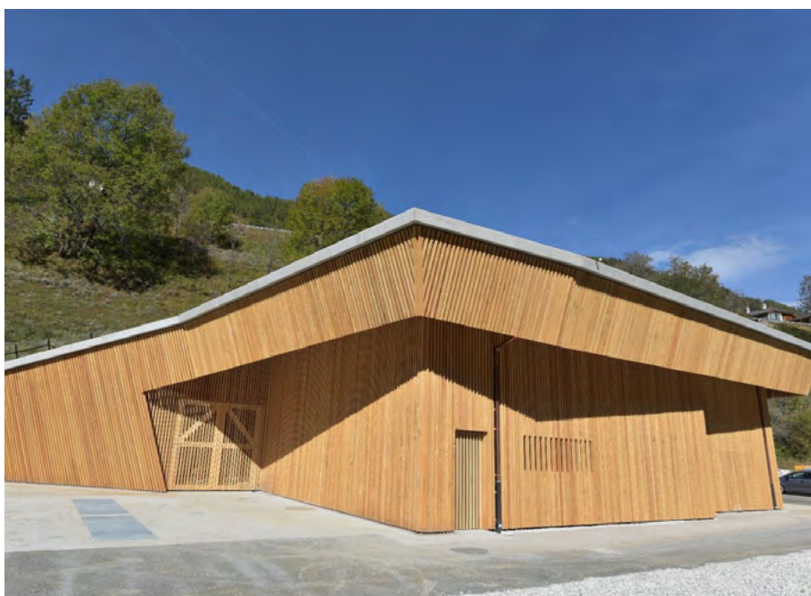
Die Zentrale des Kraftwerks Wiler-Kippel (Bild: BKW).
