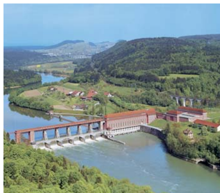
Bild 2. Laufkraftwerke tragen mit rund 30% der installierten Leistung rund 50% der Produktion aus Wasserkraft und liefern vor allem Bandlast. Im Bild das Kraftwerk Eglisau-Glattfelden am Rhein.
