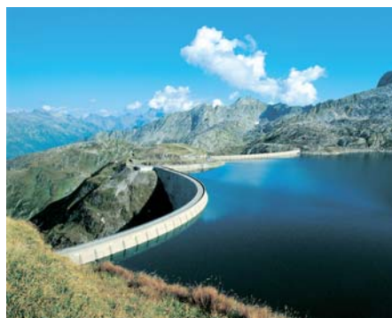
Bild 3. Speicherkraftwerke tragen die andere Hälfte der Produktion aus Wasserkraft und liefern Spitzenstrom und Regelenergie. Im Bild der Speicher Lago di Naret der Kraftwerke Maggia im Tessin.
