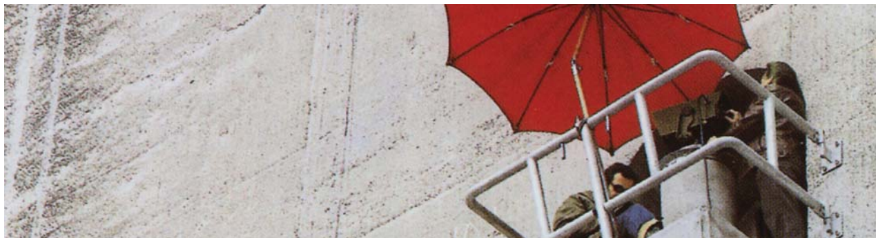
Messkampagne an einer Stauanlage.
