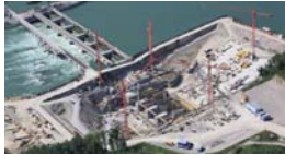
Neubau KW Rheinfelden nach 100 Jahren, Euro 380 Mio., 2003-2010
