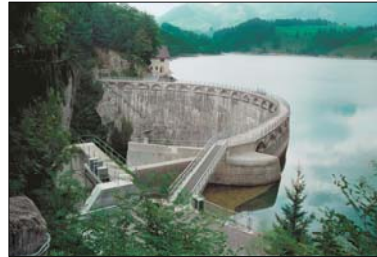
Bogenstaumauer Montsalvens bei Gruyère , vom Wasserbauer Heinrich Gruner projektiert und im Jahre 1920 als Meilenstein der Schweizer Ingenieurskunst eingeweiht
