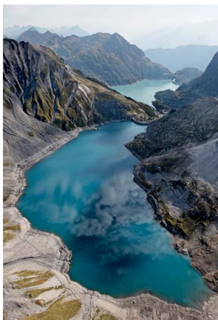
Bild 8. Die beiden Speicherseen «Vieux Emosson» und «Emosson» als Teil des PSW Nant-de-Drance (Foto: M. Martinez).
