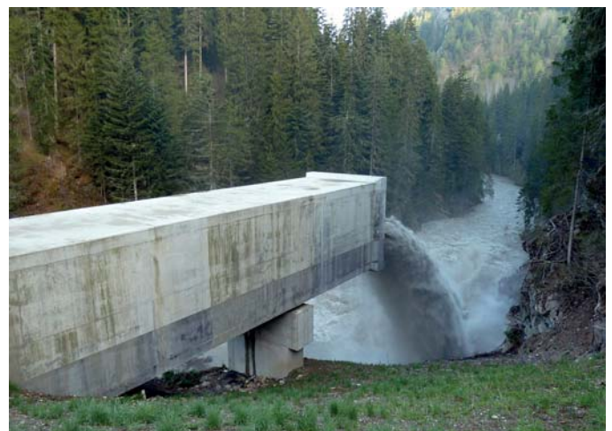
Bild 3. Bei einer Hochwassersituation führt der 2012 eröffnete Umleitstollen das Wasser der Albula am Stausee Solis (GR) vorbei und schützt diesen vor Verlandung (Foto: ewz).
