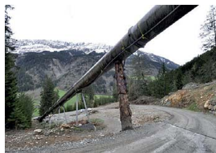
Bild 2. Die Druckleitung wird neu und mit fast doppeltem Durchmesser in die Erde verlegt (Quelle: Südostschweiz).
