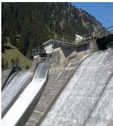
Bild 1. Die Staumauer Barcuns wird um fünf Meter erhöht (Quelle: SLF).
