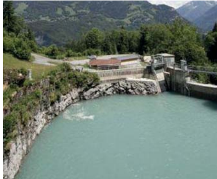
Bild. Das Kraftwerk Schattenhalb 1 (EWR).
