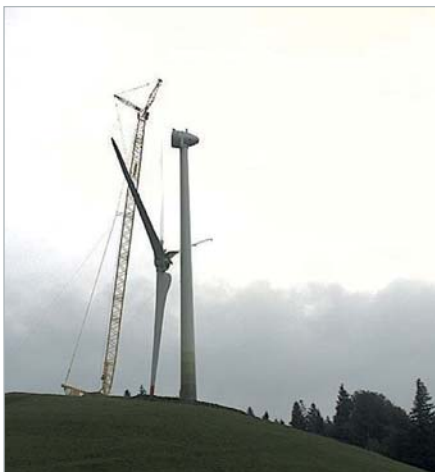
Bild 1. Montage der Rotorblätter und Nabe (Foto: CKW).
