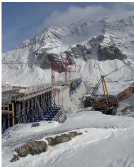
Bild 2. Die neu entstehende Mauer vor dem Wintereinbruch (Foto: SWV/Pfa, 2012).
