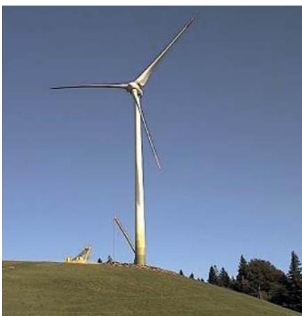
Bild 2. Fertiggestelltes Windkraftwerk (Foto: CKW).
