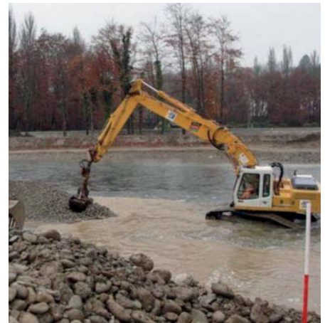
Bild. Lokale Ufersicherung mit Blöcken (Foto: zvg).
