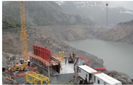
Bild 1. Fertigung des Ein-/Auslaufbauwerkes am Ufer (Foto: SWV/Pfa).
