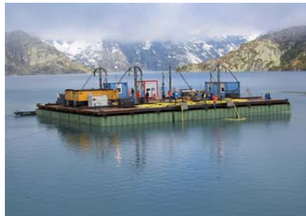
Bild 3. Und schliesslich das zentimetergenaue Absenken in den See, vom Ponton aus gesteuert (Foto: Alpiq).
