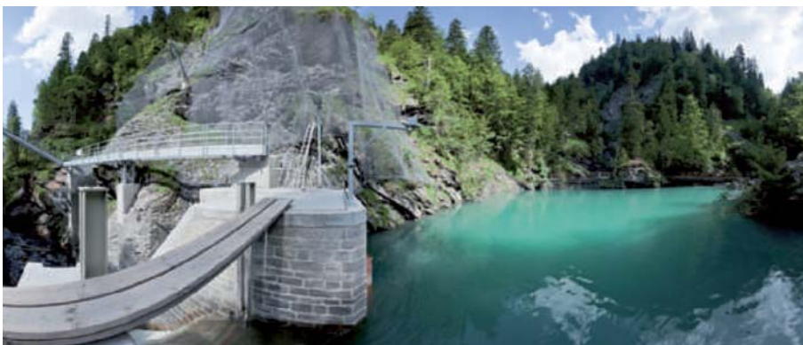
Fassung beim KW Taschinas (Quelle: repower).
