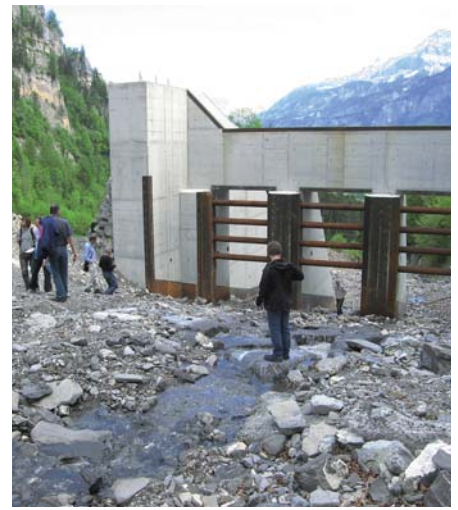
Ausleitbauwerk und Geschieberückhalt. Hochwasserschutzmassnahmen am Glyssibach, Schwanden bei Brienz (Foto: Viviroli 2011).
