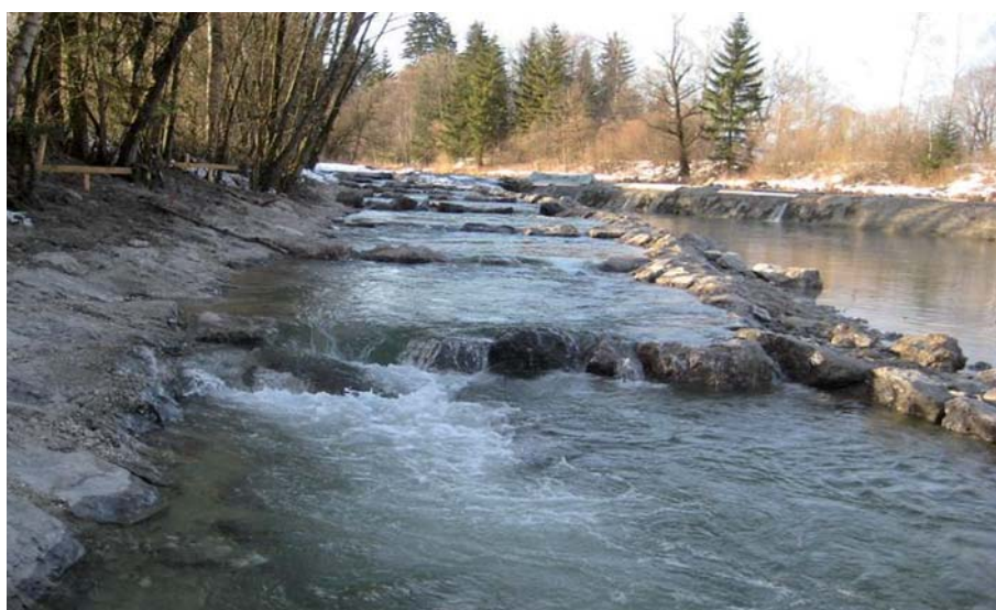
Aufstiegsanlage am Wehr Schönmühl/Loisach (Quelle: E-ON).
