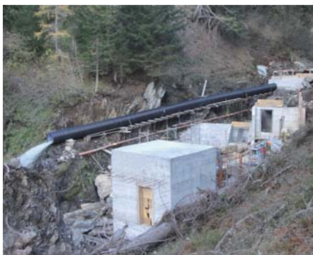
Bild 2. Rohbau von Fassung und Entsander mit temporärer Bachumleitung.
