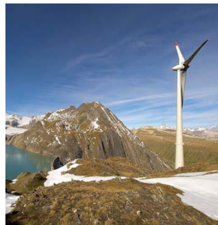
Bild. Die höchstgelegene Windenergie Europas steht am Gries im Wallis auf 2465 m ü.M. Dieser Standort in der Nähe des gleichnamigen Staudammes wurde gewählt, um die Windturbine mit den vorhandenen elektrischen Leitung verbinden zu können (Quelle: SwissWinds AG).
