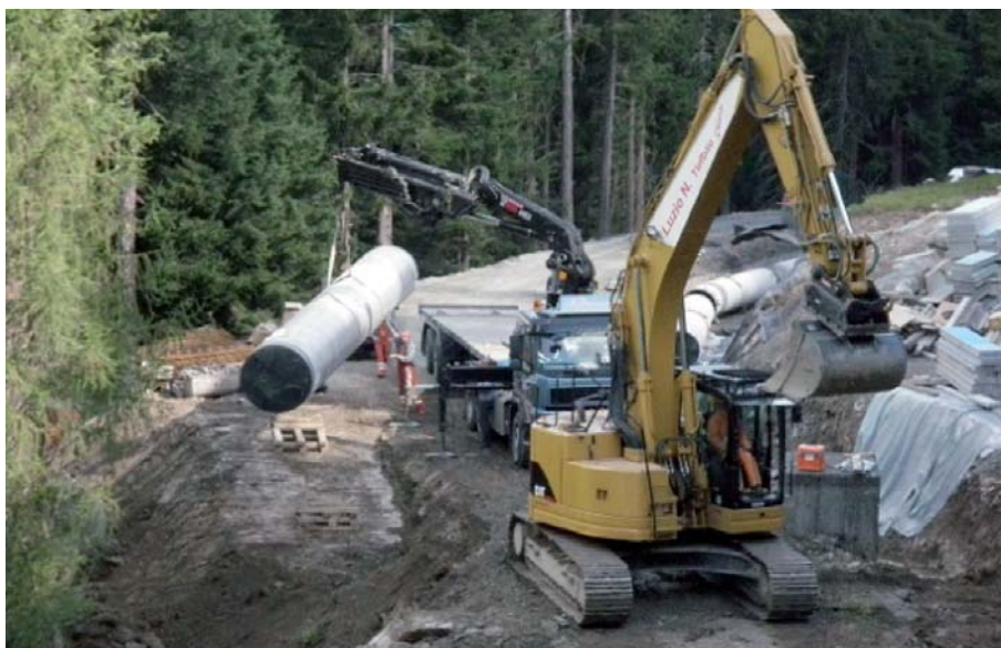
Bild 2. Einbringen der druckfesten Stahlleitung (Quelle: ewz)
