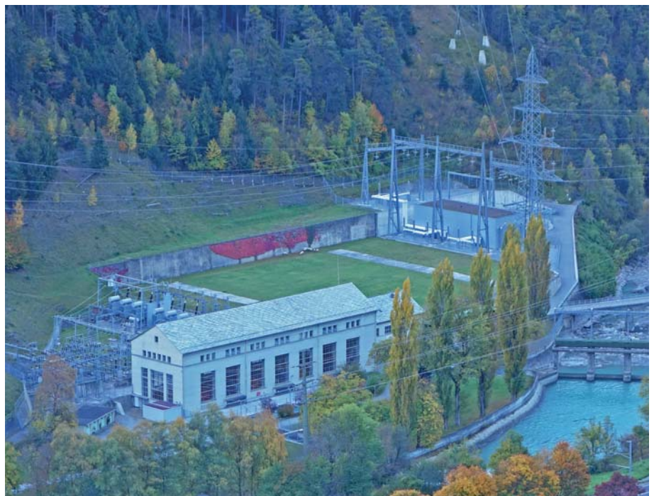
Bild 4. Wasserkraftanlage Mörel der Rhonewerke.
